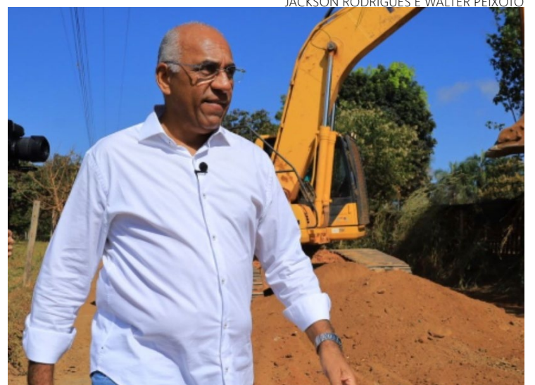
Prefeito Rogério Cruz durante visita ao canteiro de obras em rua do setor Buena Vista na manhã de quarta-feira
